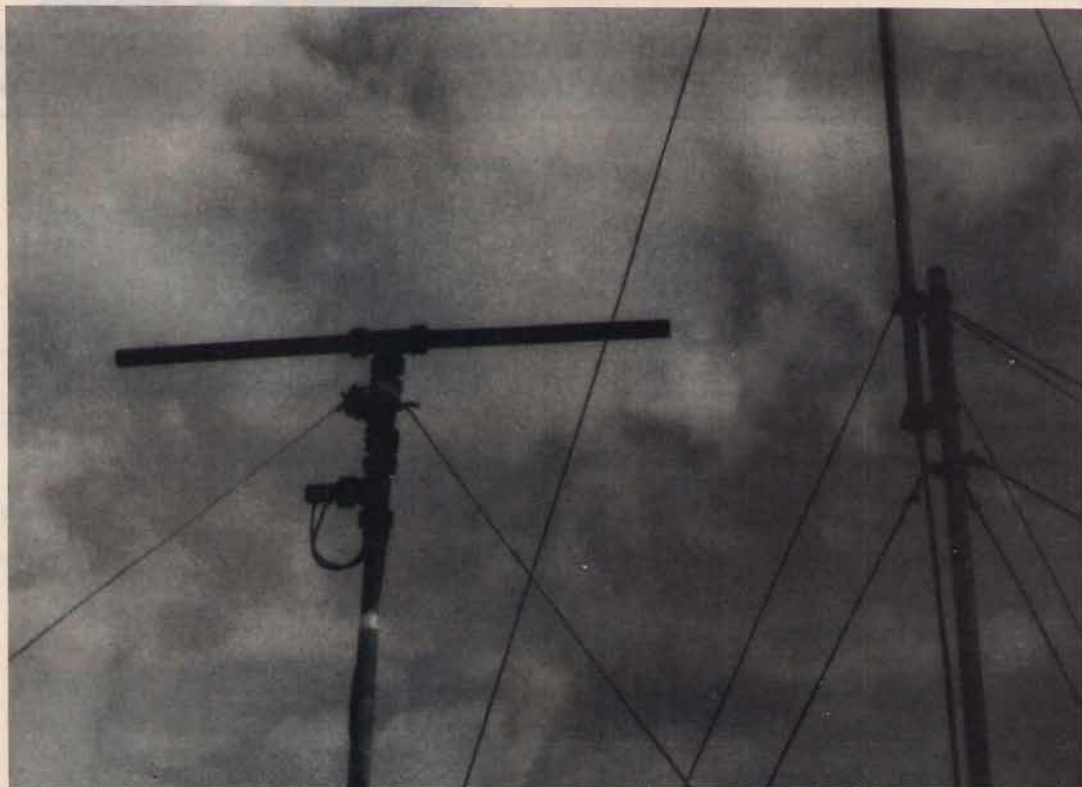
Vista più dettagliata dell'elemento ricevente e della propria struttura di sostegno, l'albero dell'antenna, e relativi elementi ricevente, ruotano liberamente all'interno del manicotto, che è bloccato dai tre tiranti, in corda nautica (e quindi fisso).
